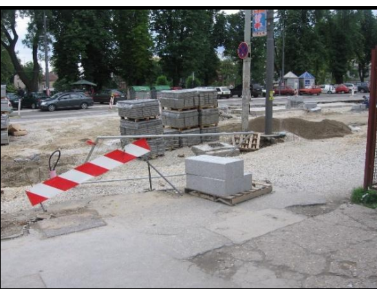
Slika br. 12 – Primeri lošeg regulisanja i usmeravanja saobraćaja u zoni radova na putu
