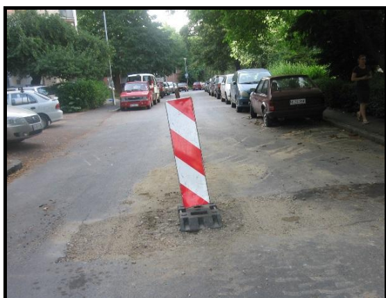
Slika br. 10 – Primeri lošeg regulisanja i usmeravanja saobraćaja u zoni radova na putu
