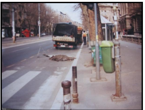
Slika br. 12 – Primeri lošeg regulisanja i usmeravanja saobraćaja u zoni radova na putu
