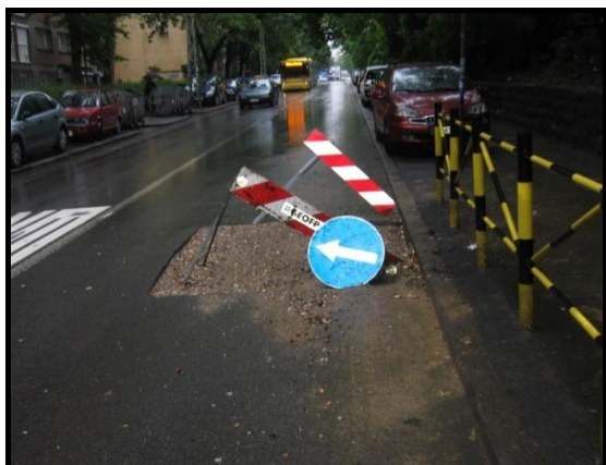
Slika br. 11 – Primeri lošeg regulisanja i usmeravanja saobraćaja u zoni radova na putu
