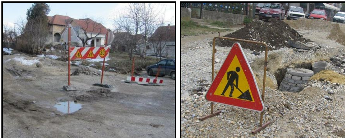
Slika br. 13 – Primeri lošeg regulisanja i usmeravanja saobraćaja u zoni radova na putu
